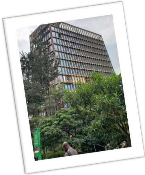
Pontificia Universidad Javeriana. Nuevo edificio – Laboratorios Ingeniería
